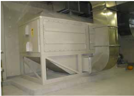
屋外排気用光触媒脱臭装置（80m 3 /min） 対象ガス：ホルムアルデヒド
